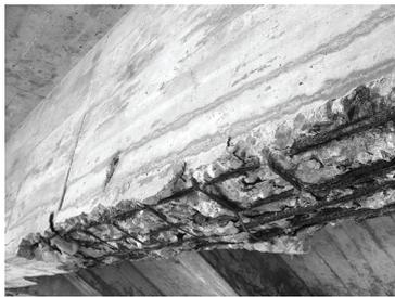
图1 码头横梁锈蚀破坏典型情况
