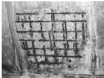
图2 码头面板底部锈蚀破坏典型情况
