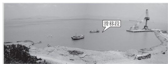
图1 1#码头滑坡后现场照片
