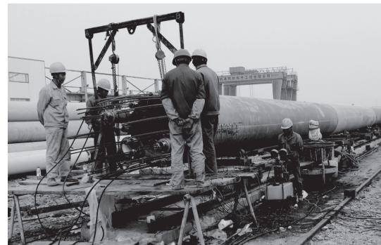
图1 大管桩分批次张拉预应力试验测试
