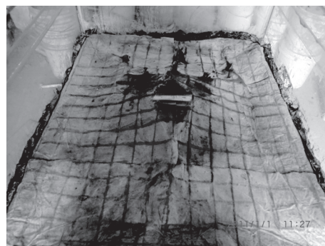
图5 真空加载后土体表面沉降
