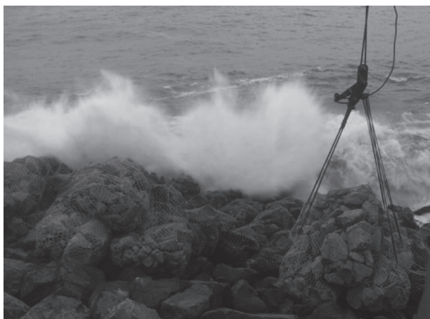
图4 波高1.5 m≤波高<2.5 m石笼防护
