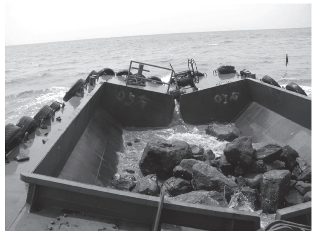
图3 开体驳就位卸载
