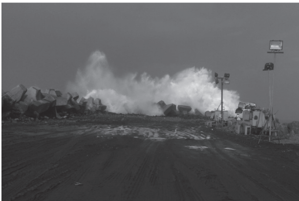
图5 波高≥3.0 m时22 t块体全断面防护
