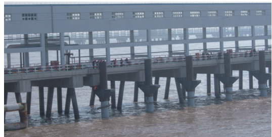
图3 受损引桥抢修后的效果
