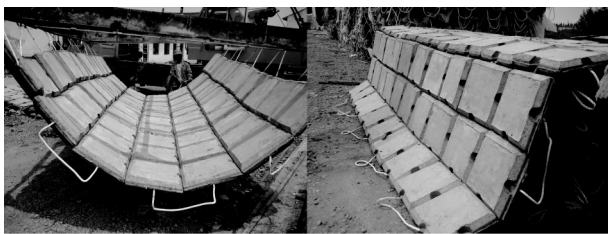
图7 混凝土连锁块脱模起吊和变形适应能力试验
