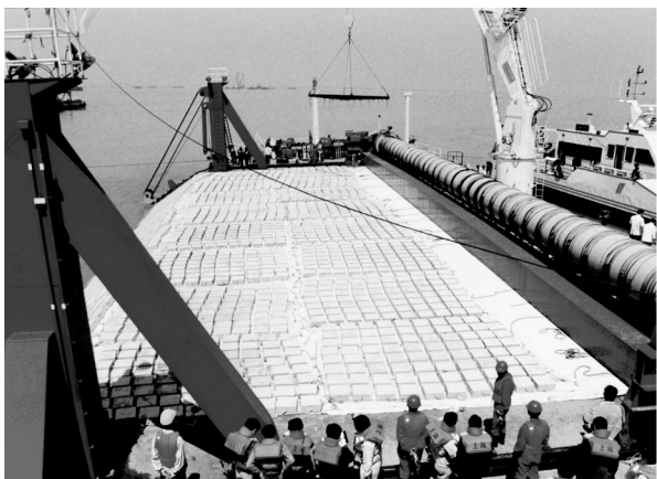
图8 专用软体排铺设船正在铺设混凝土连锁块软体排
