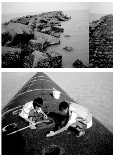
图12 利用丁坝和导堤建立的人工牡蛎礁
