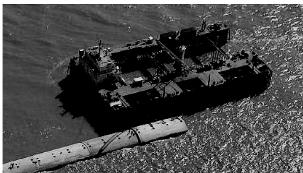
图9 半圆型沉箱安装船“安定1号”
