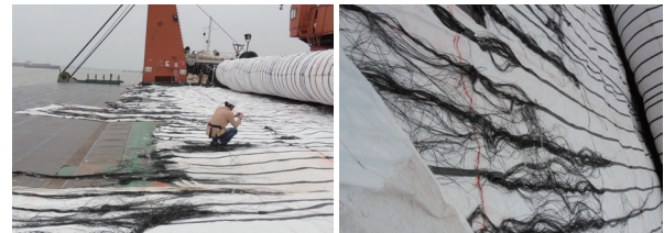
图7 混凝土连锁块软体排撕排时现场
