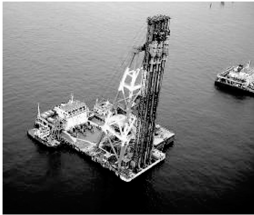
图1 挤密砂桩船施工
