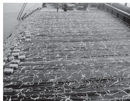
图3 排体搭接边缘设置红色检测条
