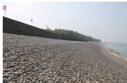
图7 藕池口工程混合式护岸结构完工效果
