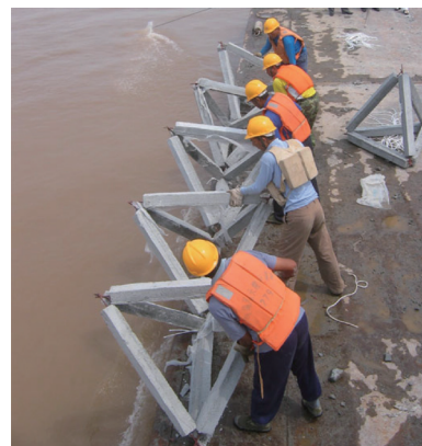
图3 人工抛投框架
