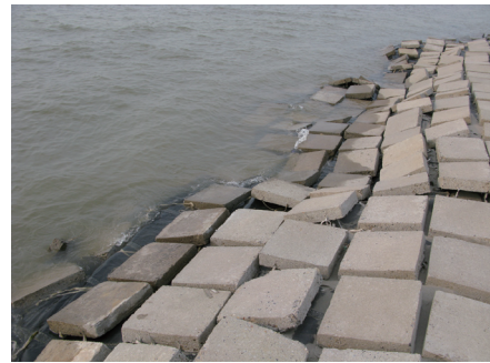
图7 损毁的护滩带
