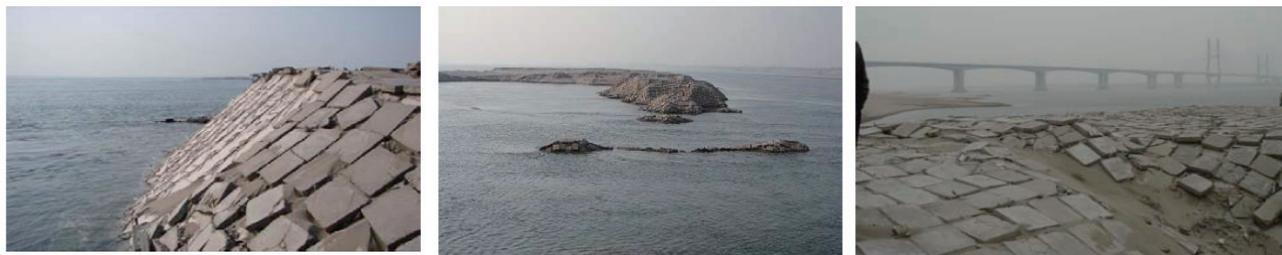
图1 沙市三八滩护滩带破坏
