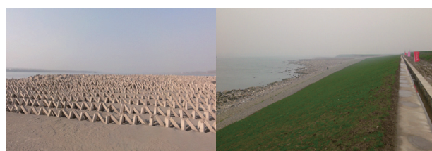
图7 透水框促淤固滩及钢丝石笼生态护坡工程实景
