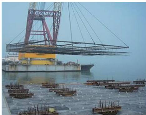
图5 钢筋笼整体吊装
