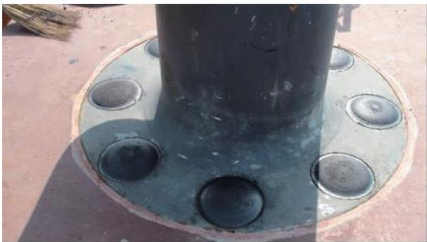
图8 沥青砂封堵整体效果
