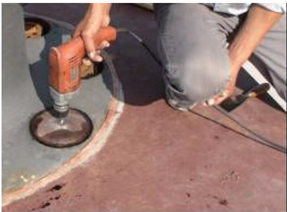
图7 电动模具磨平、磨光
