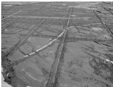
图3 排水后的淤泥区
