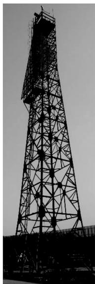
图2 钢结构桁架导标
