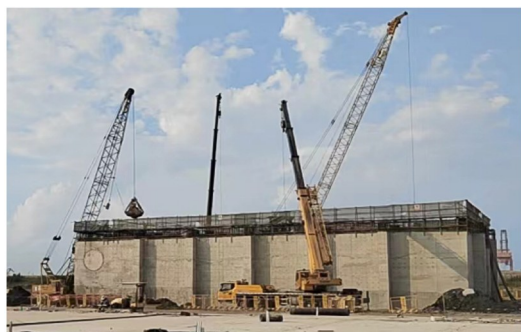
b) 调蓄池沉井结构施工
