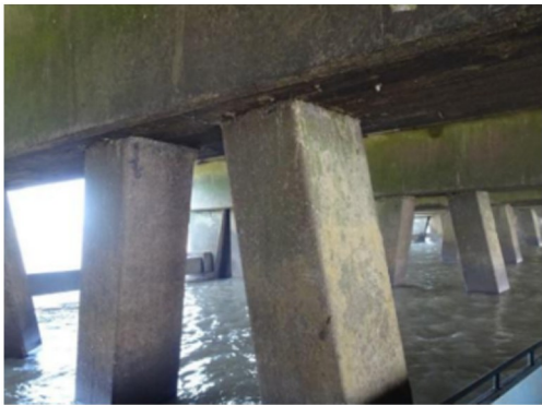
a) 罗泾一期煤炭码头
