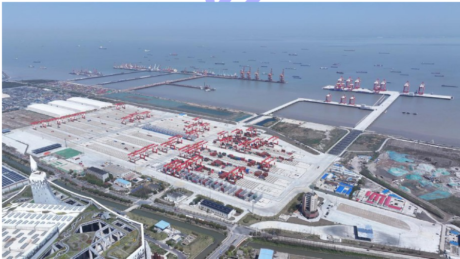
图 2 罗泾一期工程改造后港区实景
