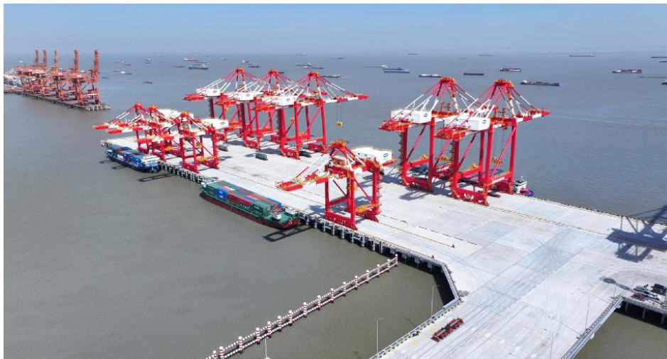
图 5 AIV 与自动化岸桥交互作业实景
