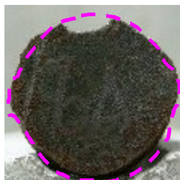
图3 除去锈蚀产物后的内部钢筋
