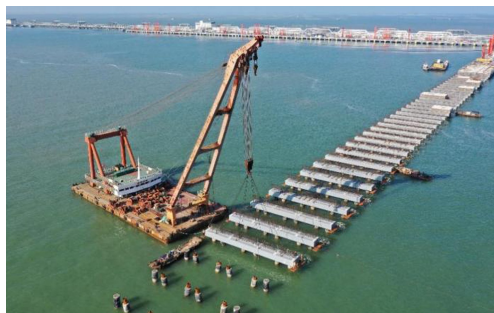
图 2 插槽式横梁安装
