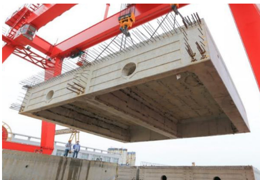
图 5 \pi 形梁板结构
