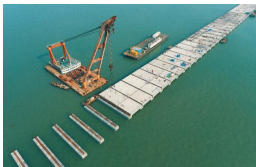
图 7 新型全装配式高桩码头构件安装
