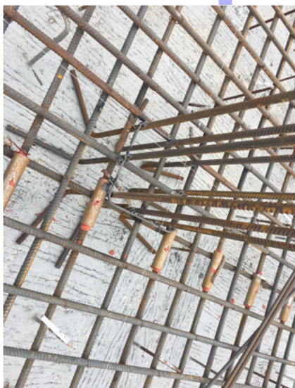
图4 墩台上的钢筋连接
