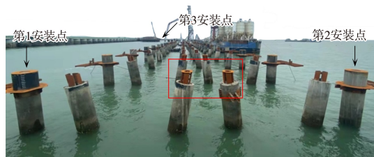
图 5 桩基排布及安装支撑设置
