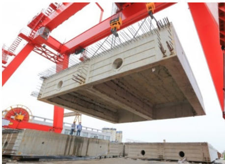
图 7 预制 \pi 形板结构
