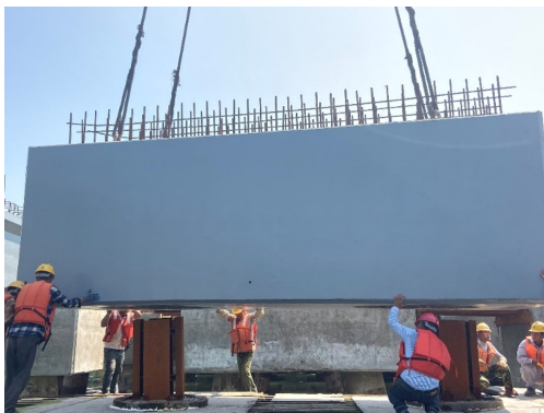
图 2 装配式桩帽试点施工
