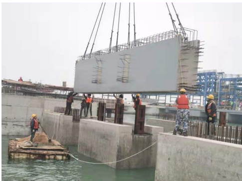
图 5 装配式横梁现场施工
