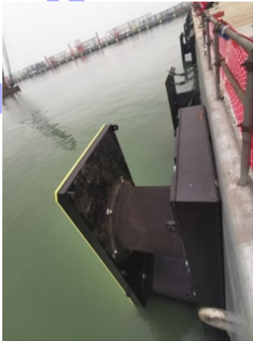
图 11 钢质靠船构件成品及安装效果
