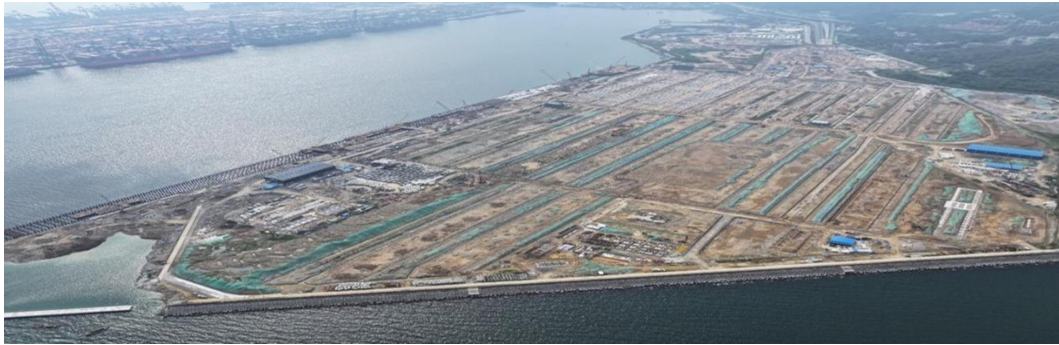
图 1 盐田港区东作业区集装箱码头一期工程道路堆场
