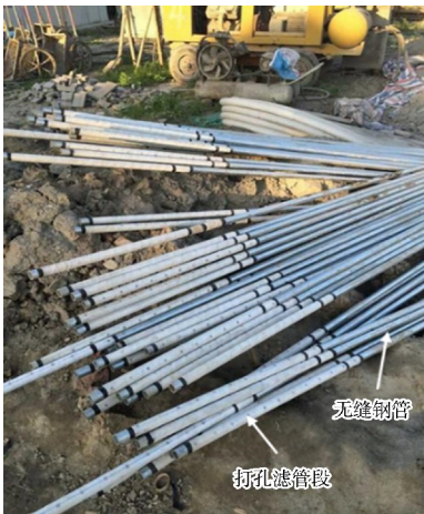
图 11 井点管构造
