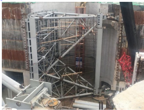
图5 人字门现场安装
