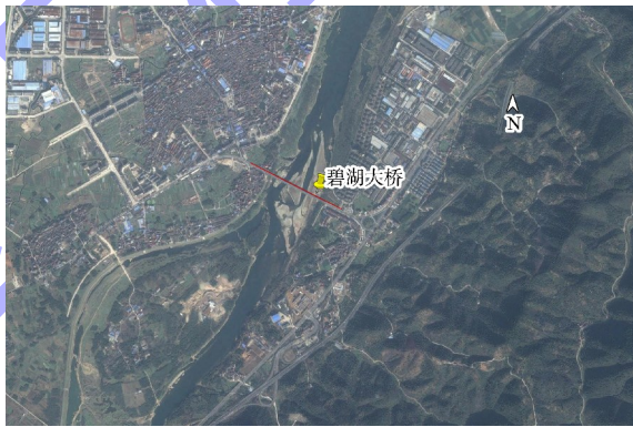
图2 桥址处滩槽情况
