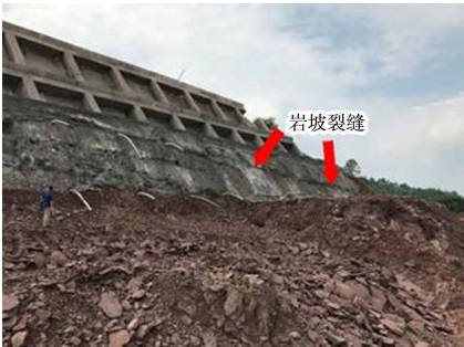
图 1 变形的边坡岩体及岩坡裂缝
