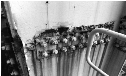
图 2 传统涂料腐蚀
