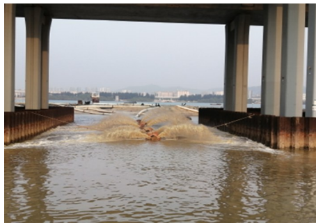
图 6 “7”字形开孔管吹填
