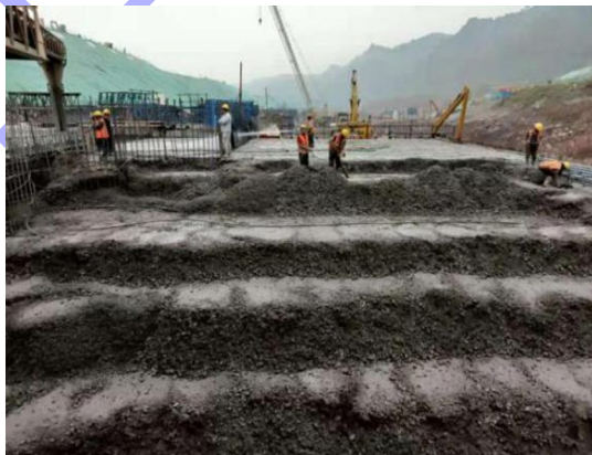
图 2 混凝土分层浇筑
