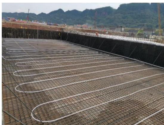
d) 冷却水管铺设
