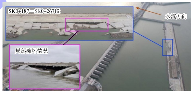
图2 上游围堰SK0+187—SK0+267段过流面破坏情况
