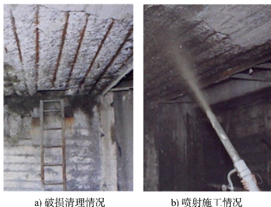
a) 破损清理情况 b) 喷射施工情况
