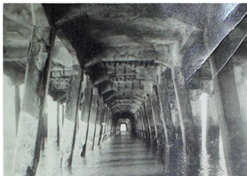
图2 某栈桥码头破损情况
