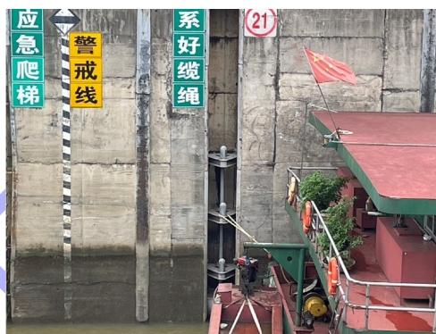
图 10 湘江长沙枢纽船闸工程铰接式浮式系船柱应用
