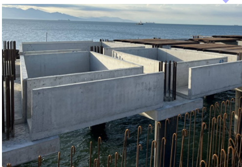
图4 U形槽现场安装
