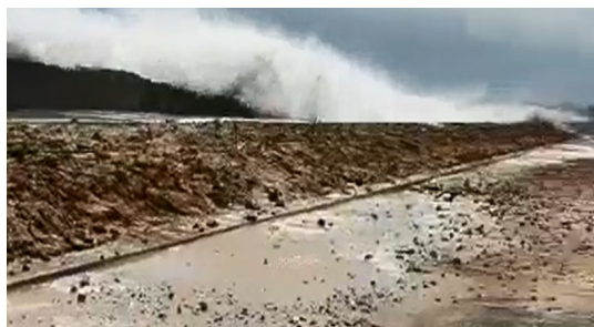
图 2 工程第一次实施后的越浪情况
