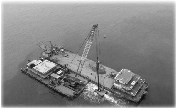
图 3 驳船布锚定位打桩施工现场
