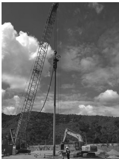
图1 底部出料法施工的东帝汶Tibar港工程现场
