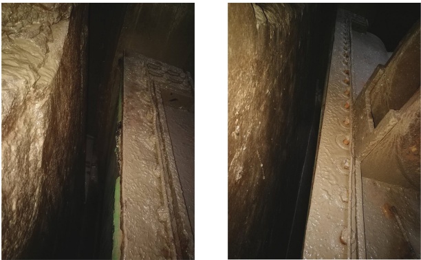
a) 顶止水中部偏右侧约 300 mm 断裂 b) 顶止水中部至右侧共 8 颗螺栓不同程度松动
