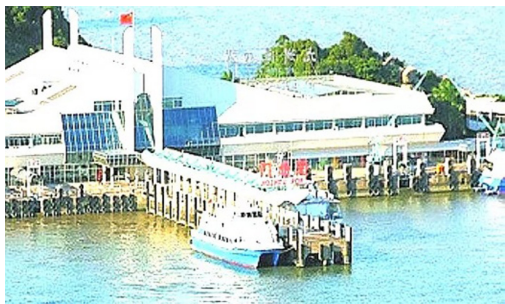
图5 设置靠船立柱的码头
