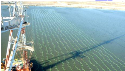
图 4 集水管与排水软管连接
