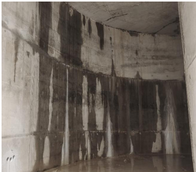
图 1 廊道混凝土开裂
