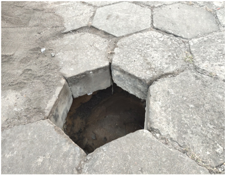
图 3 漏砂空洞
