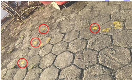
图 8 钻孔加密布置
