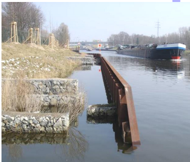
图 3 德国斯普雷河板桩复合护岸
