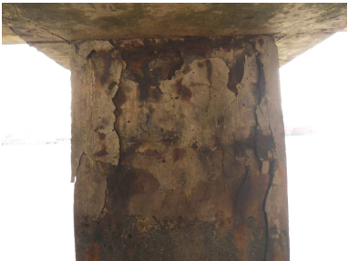
a) 混凝土桩基保护层脱落
