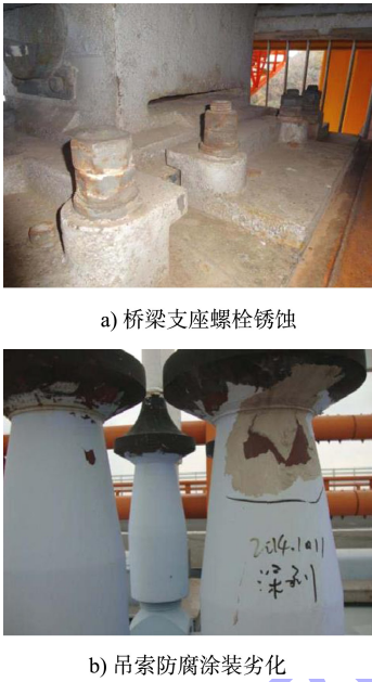
图 10 西堠门大桥构件腐蚀情况
