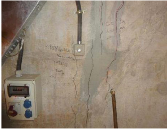
d) 桥梁锚碇混凝土结构裂缝
