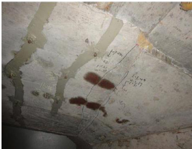
c) 桥梁钢混结合段处混凝土箱梁裂缝
