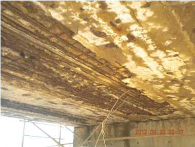
b) 梁板底部钢筋锈蚀
